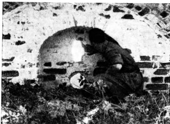
Рис. 4. Подошвенный бой южной стены Большого Кириллова монастыря.
