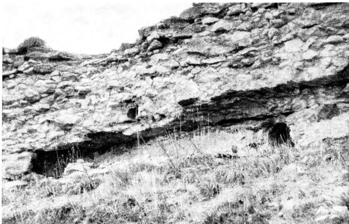
Рис. 14. Каналы деревянных связей в юго-западной стене Гдовского кремля.
