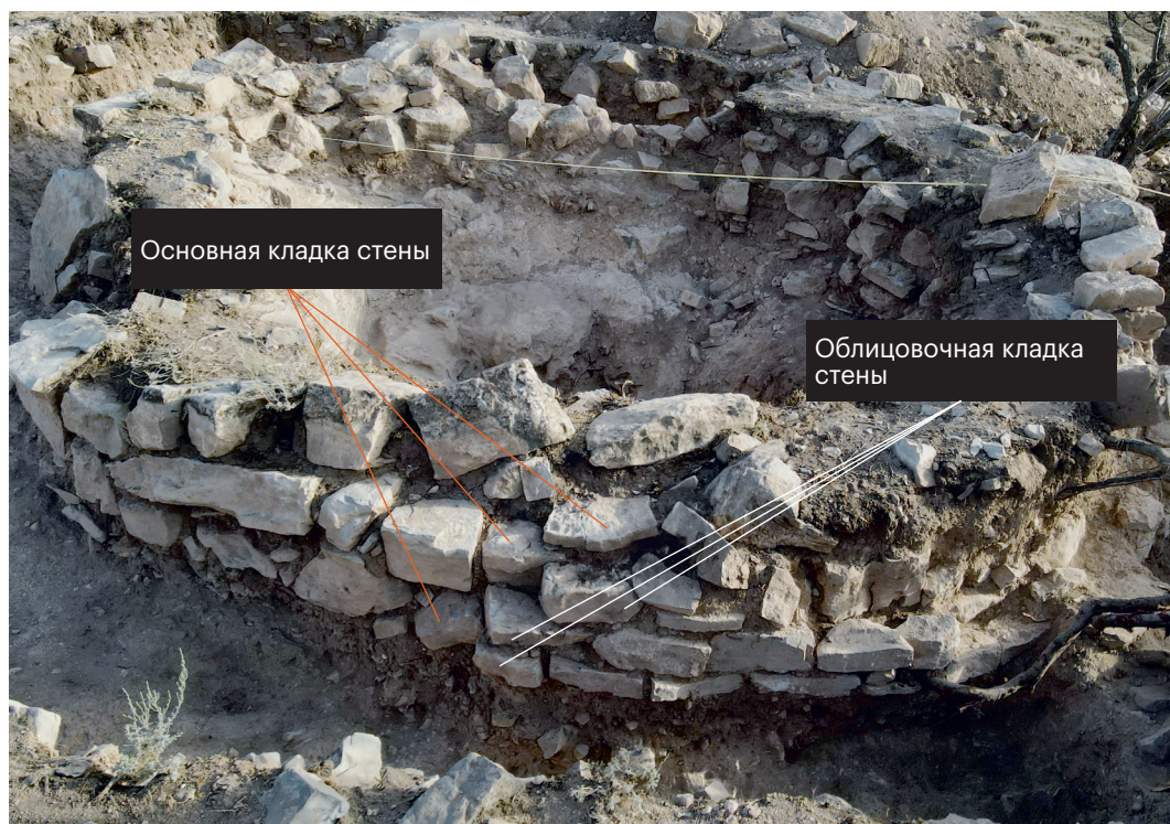
Рис. 5. Башня 2, облицовка стены. Южный фас.
