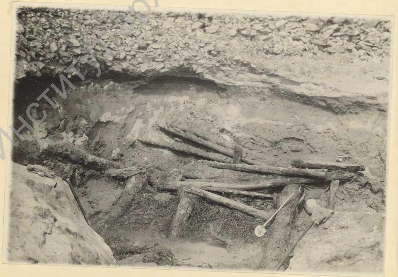
Балки над камерой.
