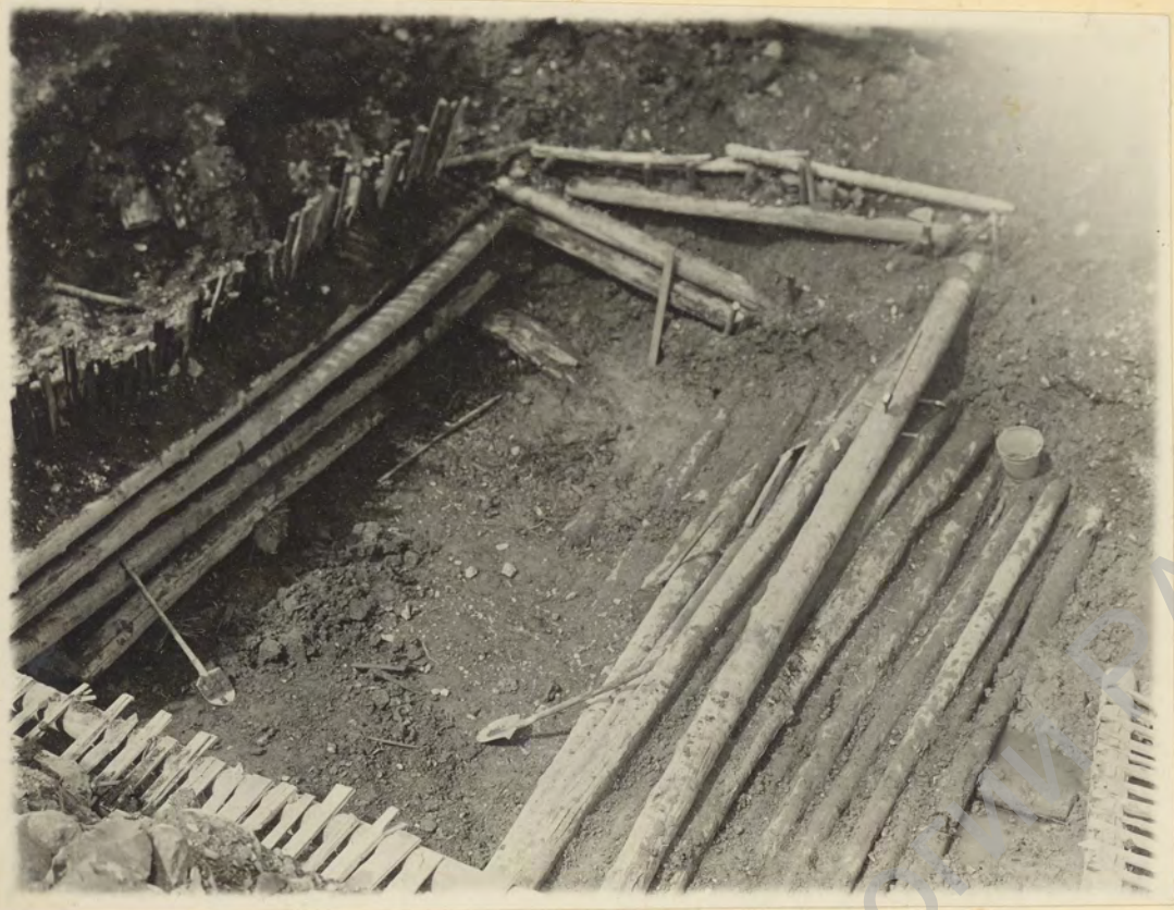
перед началом работ №2.
