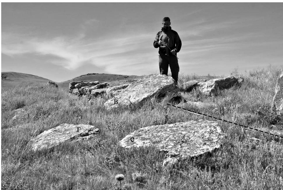
Рис. 2. Отбрасывание камней во время сильного землетрясения. Южная городская стена городища Сююрташ. «в», «г», «е» – нумерация каменных блоков, слетевших со стены к востоку. Прерывистая линия – продолжение восточного фасада стены № 2, её видно под камнем «в»
