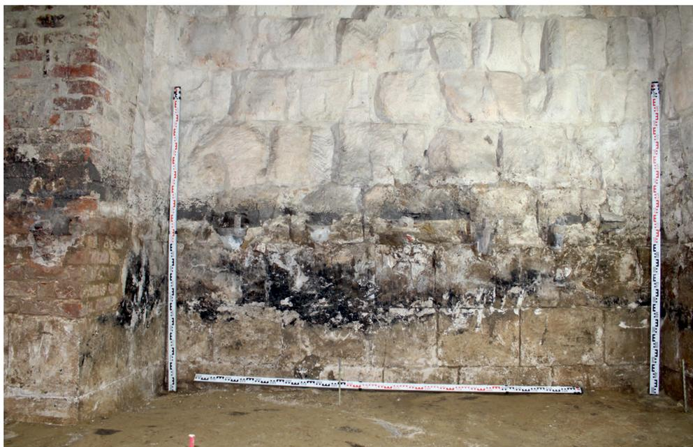
Рис. 3. Белокаменные блоки нижних рядов кладки стен и контрфорсов Золотых ворот
