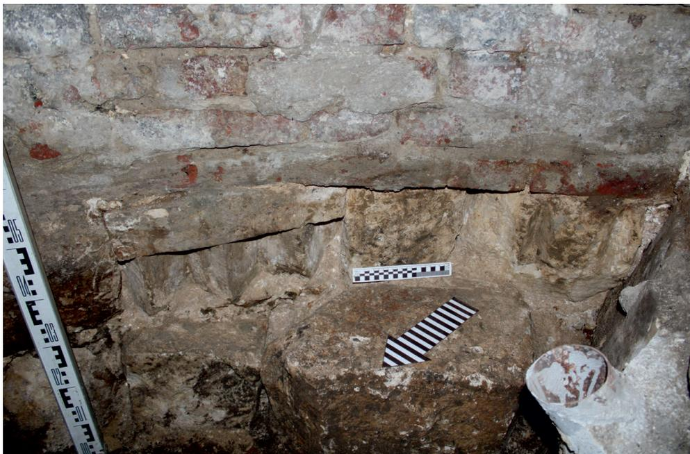
Рис. 7. Фрагменты поребриков, забутованные в фундамент северо-восточной башни
