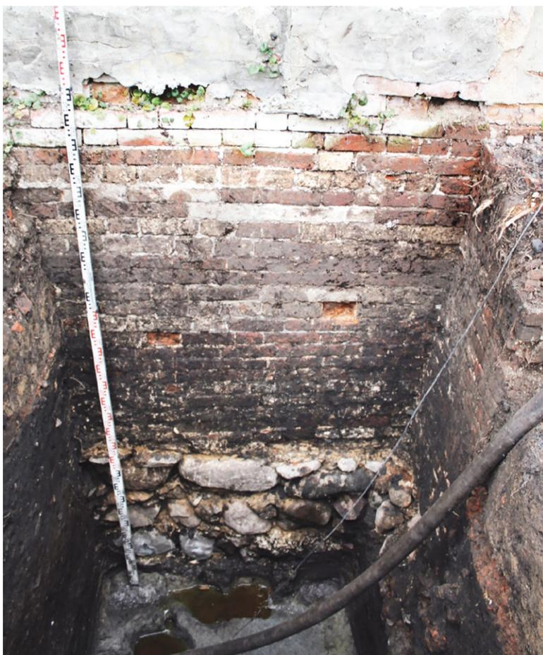
Рис. 7. Фундамент и кладка южной стены колокольни (северная стенка шурфа 3)
