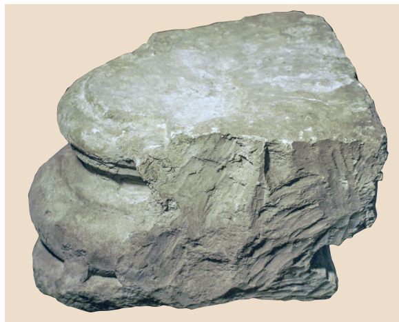
Ил. 1. Белокаменный блок цокольной части стены Рождественского собора с «аттическим» профилем XIII в. и XV в. на его противоположных гранях
