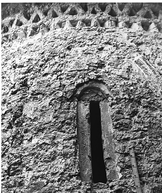
Ил. 6. Фото правого (северного) окна средней абсиды церкви Успения. Видны следы древнего валика аркатуры. 1959 г. ПМЗ. Дрвелехранилище. НВ-6883(5-6)-002
