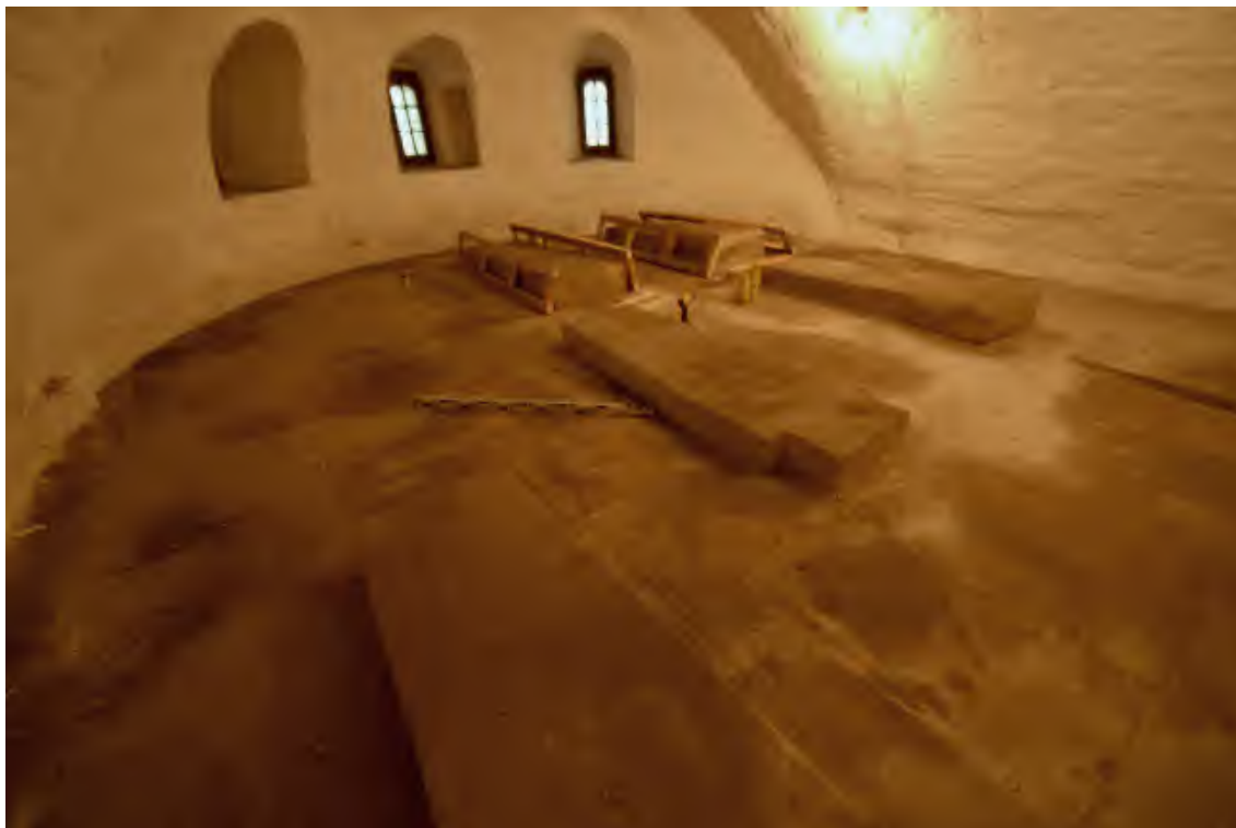
Рис. 2. Подклет Смоленского собора. Центральная апсида. Вид с северо-запада в начале работ.
