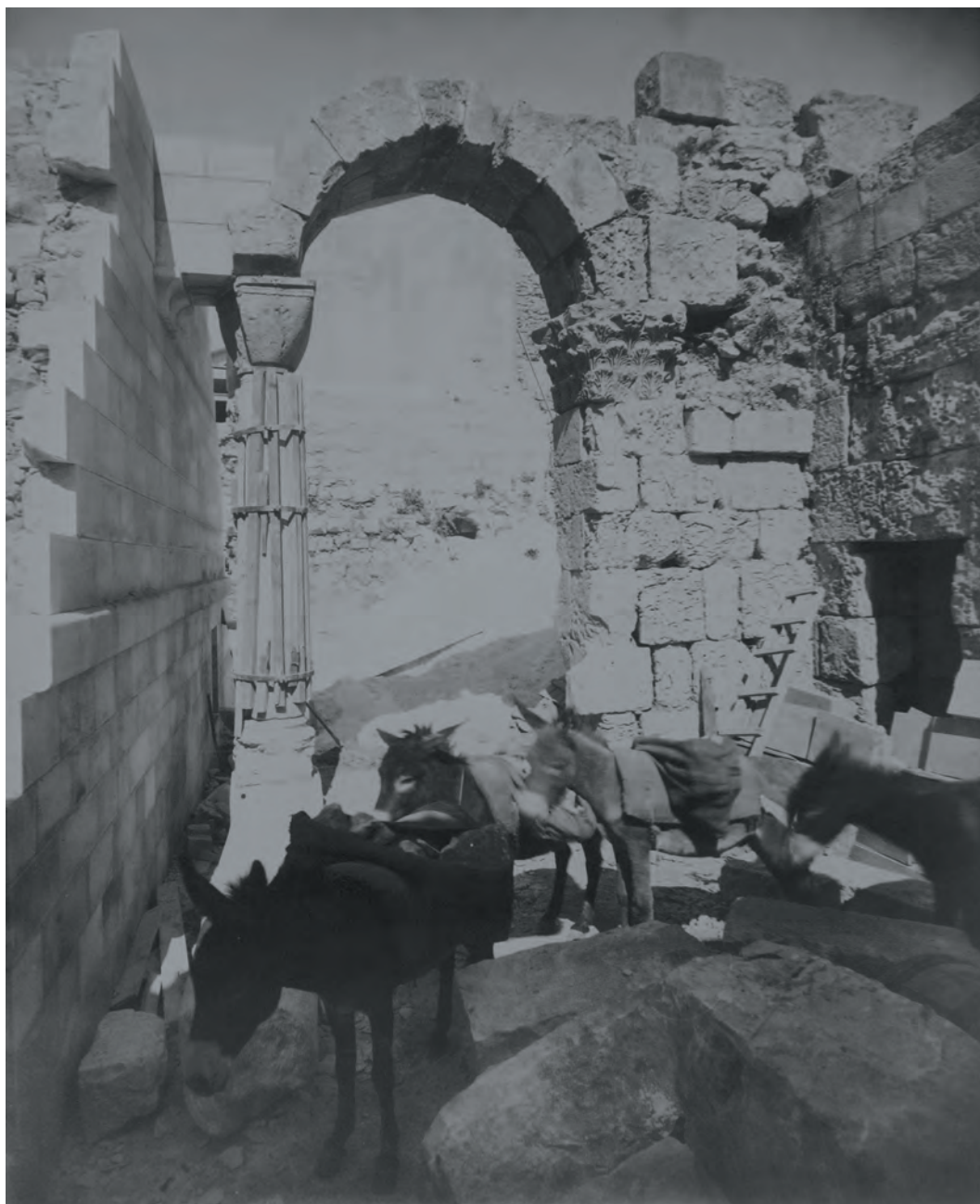
Рис. 7. Вид арки с востока, после замены капители, укрепления колонны и реставрации свода. 1888–1889 гг. Фото 1889 г.
