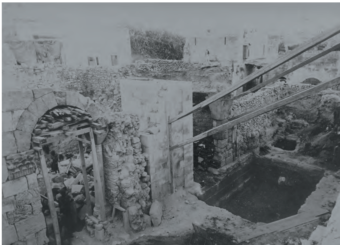
Рис. 6. Арка в момент строительства здания подворья на русских раскопках. С юга возводится стена, поставленная на фундамент, под которым виден фрагмент древней кладки. 1888 г. Фото 1888 г.
