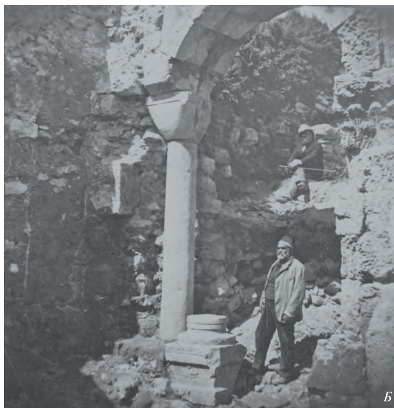
Рис. 3. Вид раскопанного арочного проема с запада. Стоят Симос Сердис с помощником. Видны утраты северной части капители. На заднем плане пролом в стене, сделанный для поисков фундамента южной части сооружения. Фото. 1883 г. (А). Симос Сердис возле найденной под пролетом арки базы колонны. На заднем плане сидит К. Шик (?). Фото. 1883 г. (Б). Здесь и далее — фото из коллекции фотографий ИППО. ГМИР (Санкт-Петербург).
