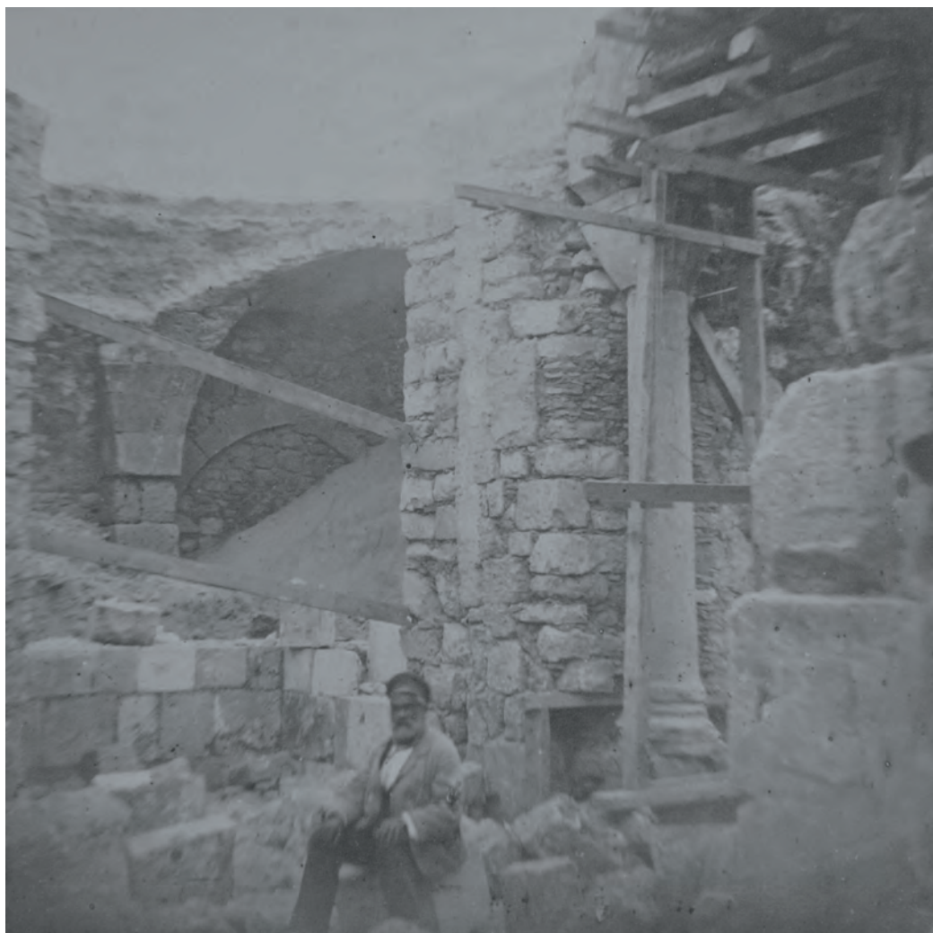
Рис. 4. Работы по реконструкции арки в октябре 1884 г. На заднем плане кладется третий ряд южной части сооружения, на переднем — сидит Симос Сердис. Фото 1884 г.
