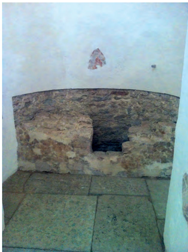
Рис. 2. Церковь Георгия в Старой Ладогe. Конструкция в северной апсиде, вид с запада.
