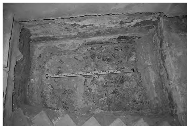
Рис. 3. Бутовая кладка фундамента в приделе Разделения Риз (шурф 16/2011). Вид с северо-запада.
