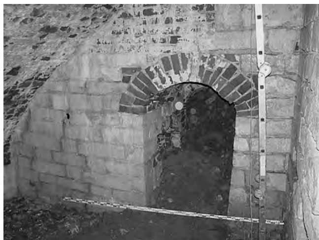
Рис. 3. Сводчатые субструкции, открытые под основанием Ефремовой башни (2010 г.).
