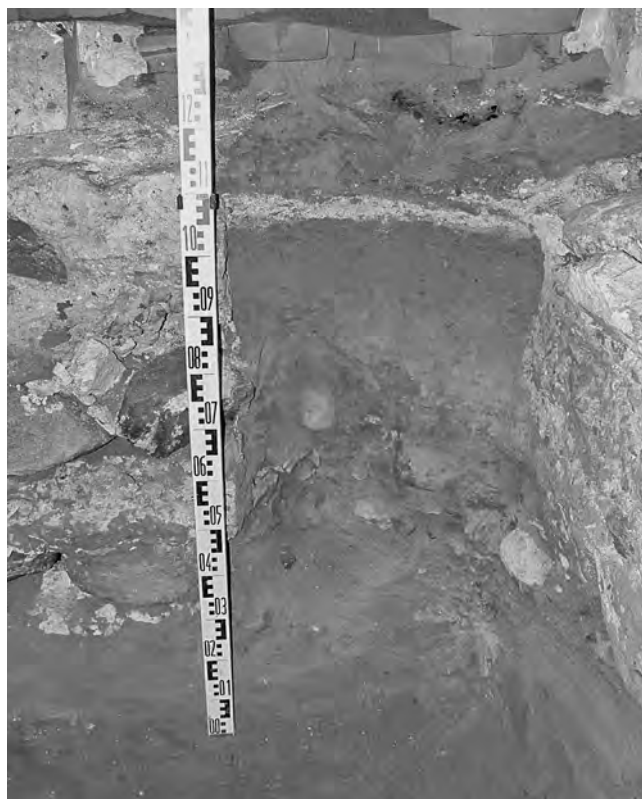
Рис. 2. Типичный профиль предматерикового слоя и геологических отложений между фундаментными кладками в интерьере собора.
