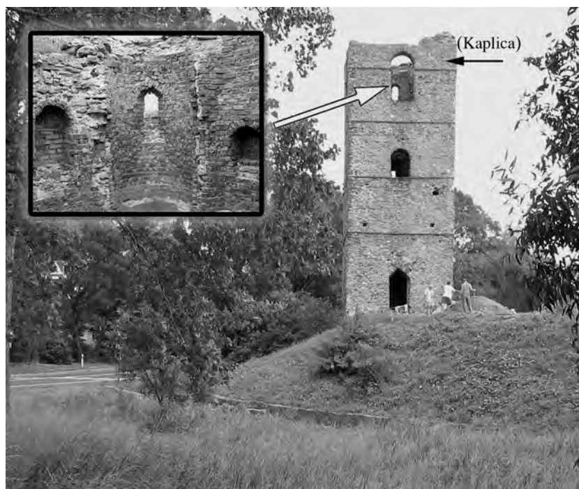
Рис. 5. Башня и связанный с ней комплекс в Столпе. Вид с запада. На врезке – вид изнутри. Фото А. Буко.
