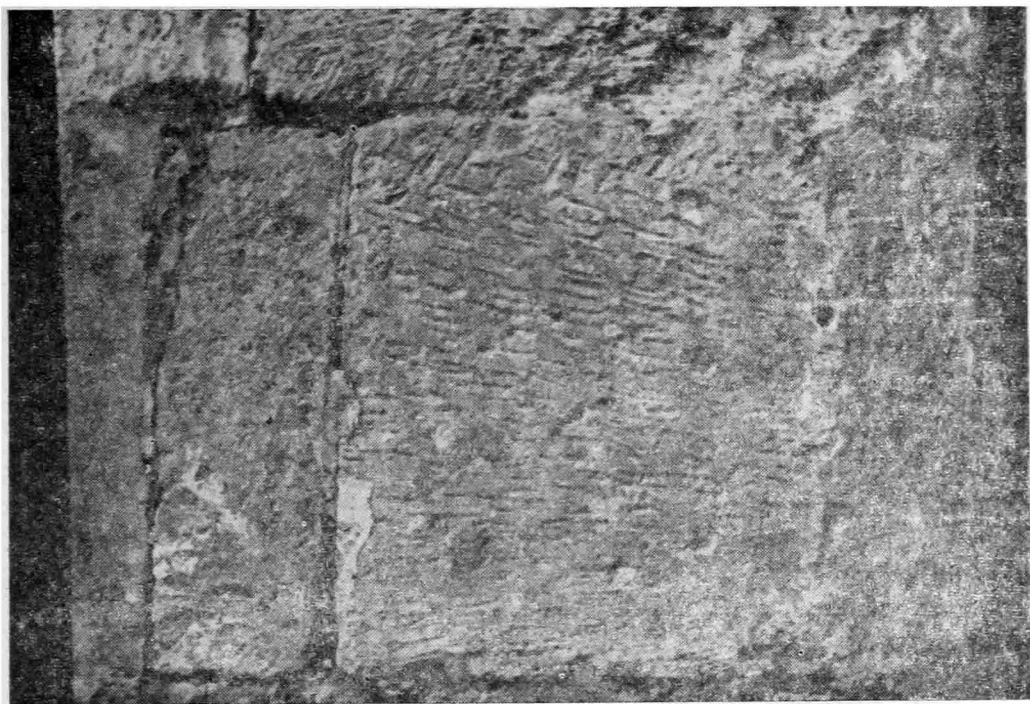
Рис. 2. Кладка северного фасада Рождественского собора в Боголюбове. Обработка тесовиком с прямым лезвием
