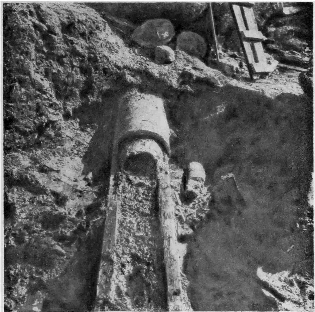
126. Шиповое соединение концов водоотводных труб.
