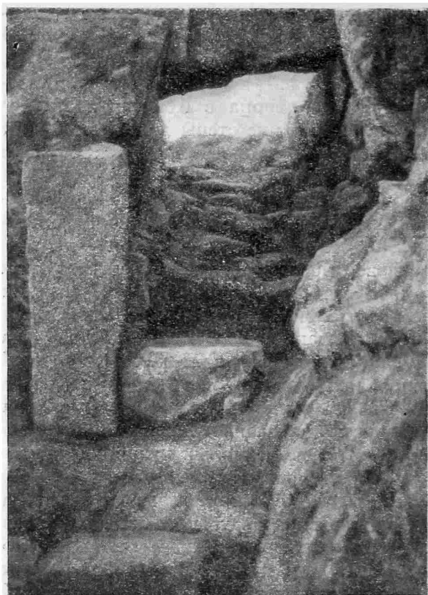
Рис. 37. Херсонес. Лестница со двора в кладовую (помещ. 16)
