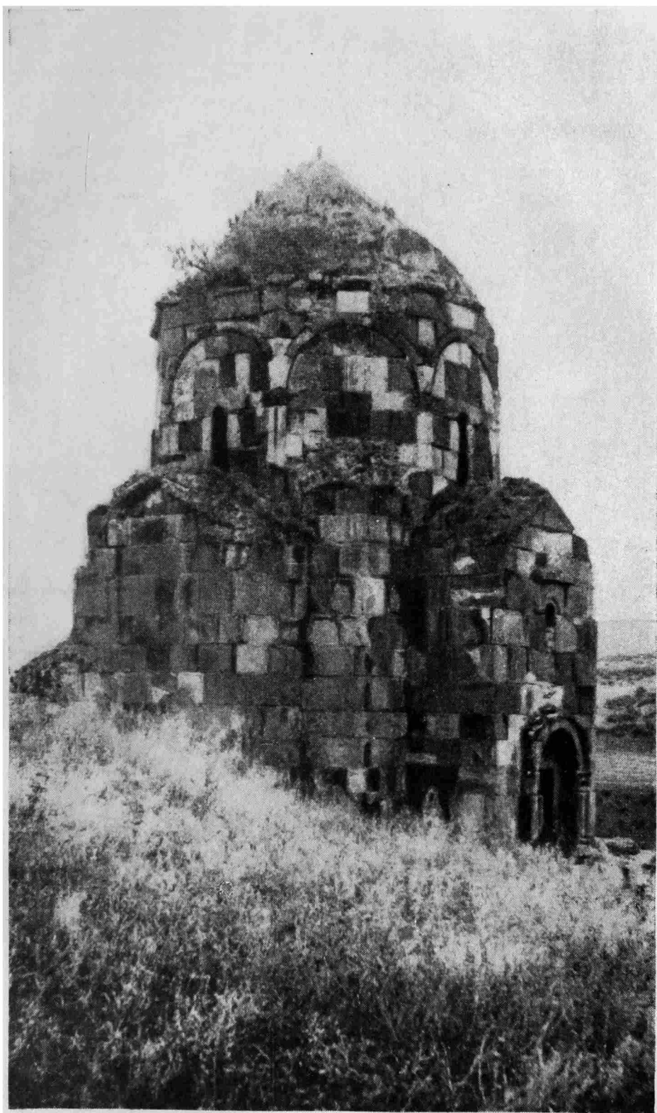
Рис. 15. Общий вид здания с сев.-зап. стороны
