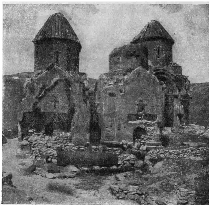
Рис. 6. Армения. Багнайр. Общий вид трех церквей
