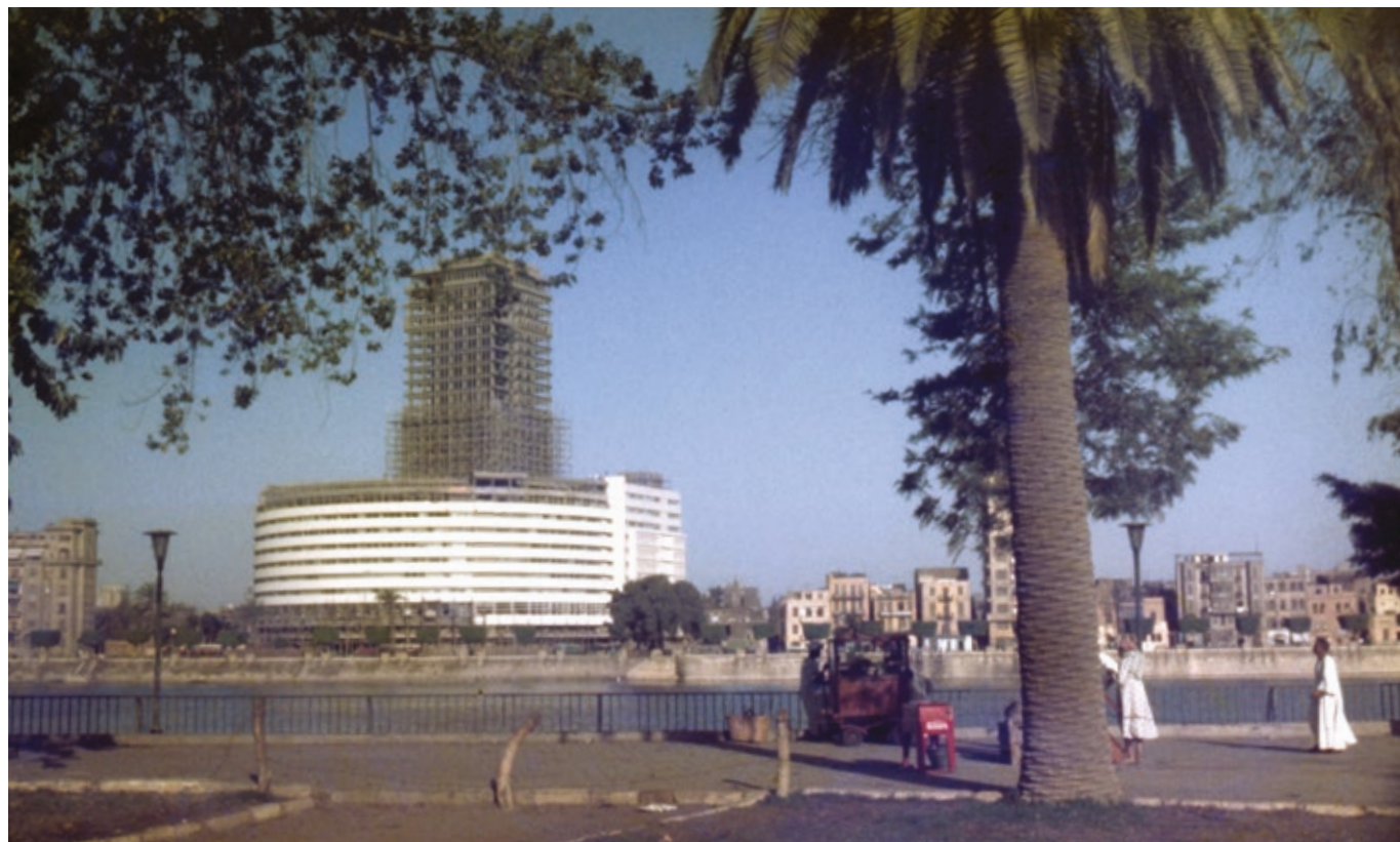
Ил. 116. Каир. Вид на строящееся здание телецентра Fig. 116. Cairo. View of the television centre building under construction
