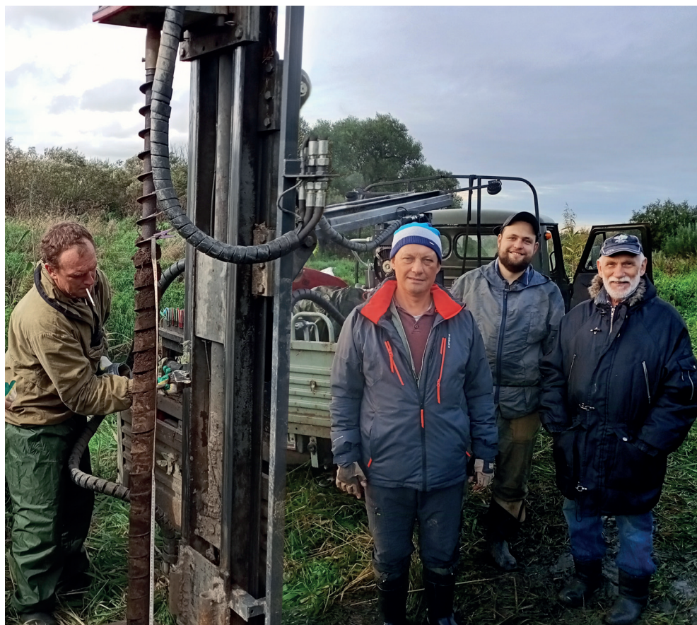
Рис. 3. В процессе буровых работ в октябре 2021 г.
