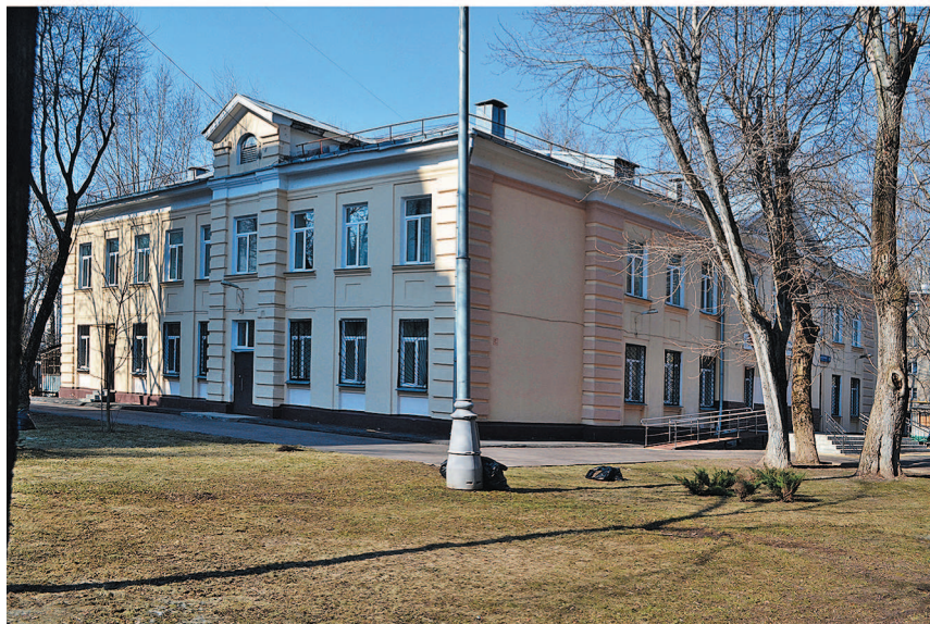
69. Ховрино, «2-й Пост». Здание бывшей школы № 41 Октябрьской железной дороги. Школа построена в 1954 году. Ныне — Колледж предпринимательства № 11. Фото 11 апреля 2021 года
