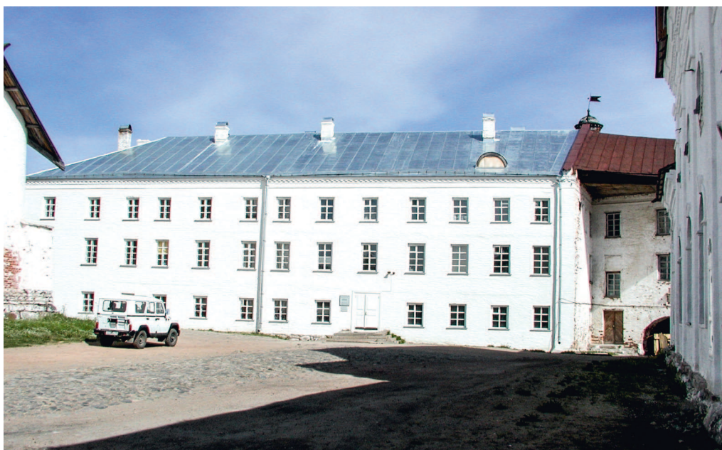
Илл. 4. Новобратский корпус постройки 1823 г. Вид с запада после реставрации 2000–2002 гг. Внутри него в южной части, обращенной четырьмя крайними правыми окнами на монастырский двор, заключены остатки кельи № 40, в которой располагались котельная и оконничная мастерские XVII–XVIII вв.
