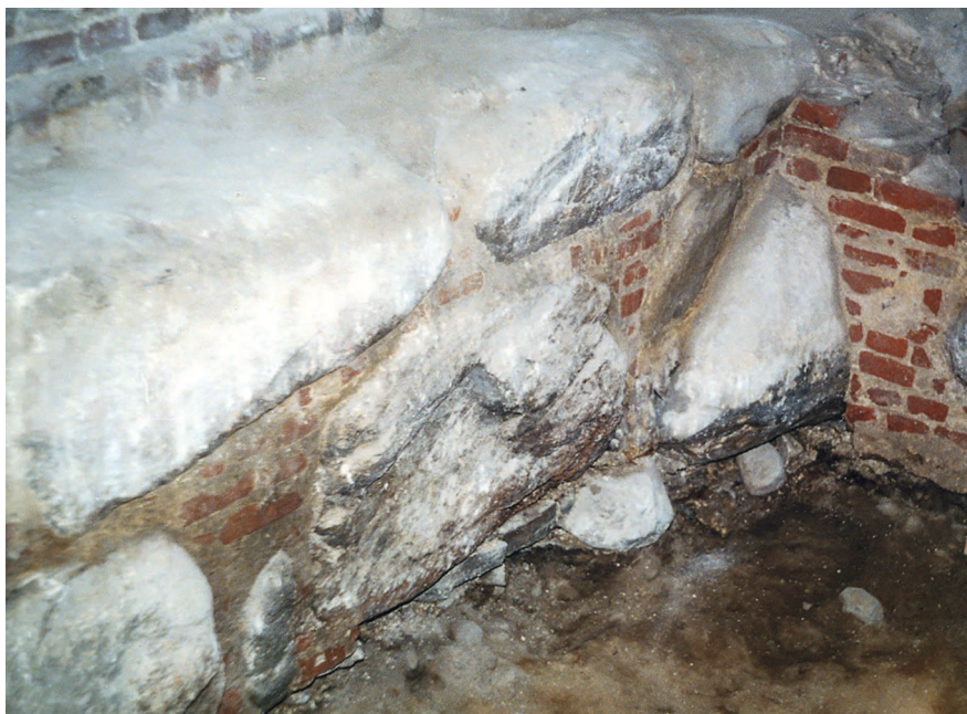
Илл. 22. Келья № 40. Раскоп 7, участок В. Цокольное подполье котельной мастерской – медеплавильни. Зачистка на уровне материка. «Подпорная стена» XVII в. Стоявшая на ней кирпичная стена была разобрана в 1823 г. при строительстве Новобратского корпуса. Вдали – северная стена подполья. Общий вид с юго-востока. 2000 г.
