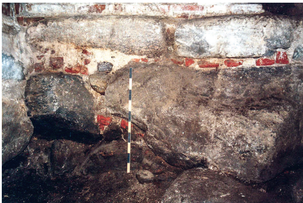
Илл. 52. Келья № 40. Вертикальный след известковой полосы на валунном цоколе задней кельи в месте примыкания восточной кирпичной стены коридора. Раскоп 3, участок Б. Вид с севера. 2000 г.
