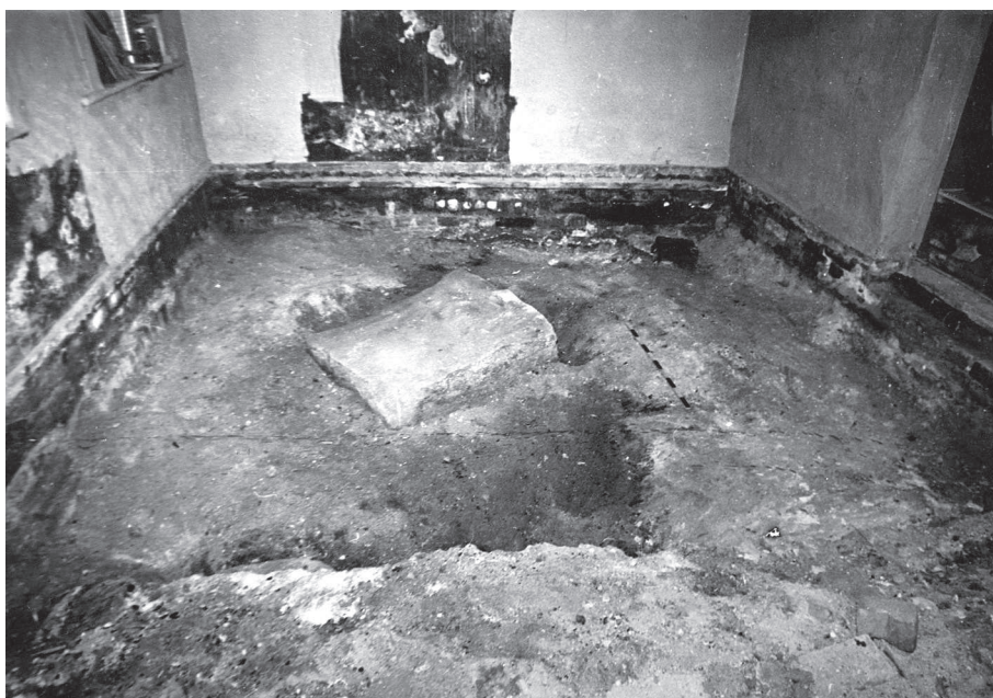
Илл. 44. Келья № 40, задняя келья. Раскоп 3. Зачистка после снятия мусора по верху известковой стяжки 1823 г. В центре – плоская гранитная плита. Вид с севера. Фото Ю.Б. Гендина. 2000 г.
