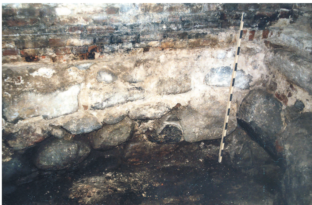
Илл. 53. Восточный цоколь кельи иконописцев 1804 г. Вид с запада, изнутри подвала. 2000 г.
