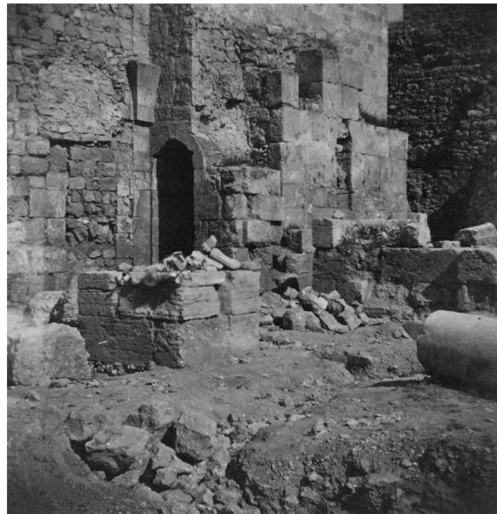
Северо-западный угол русского участка до начала раскопок. Фото архимандрита Антонина (Капустина). 1883 г. ГМИР
