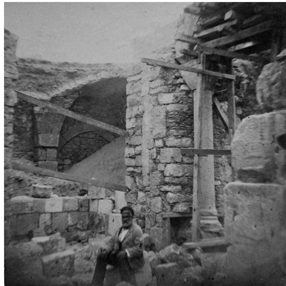
Симос Сердис, руководитель работ по реконструкции древних ворот. На заднем плане кладется третий ряд южной части сооружения. Фото архимандрита Антонина (Капустина). Октябрь, 1884 г. ГМИР
