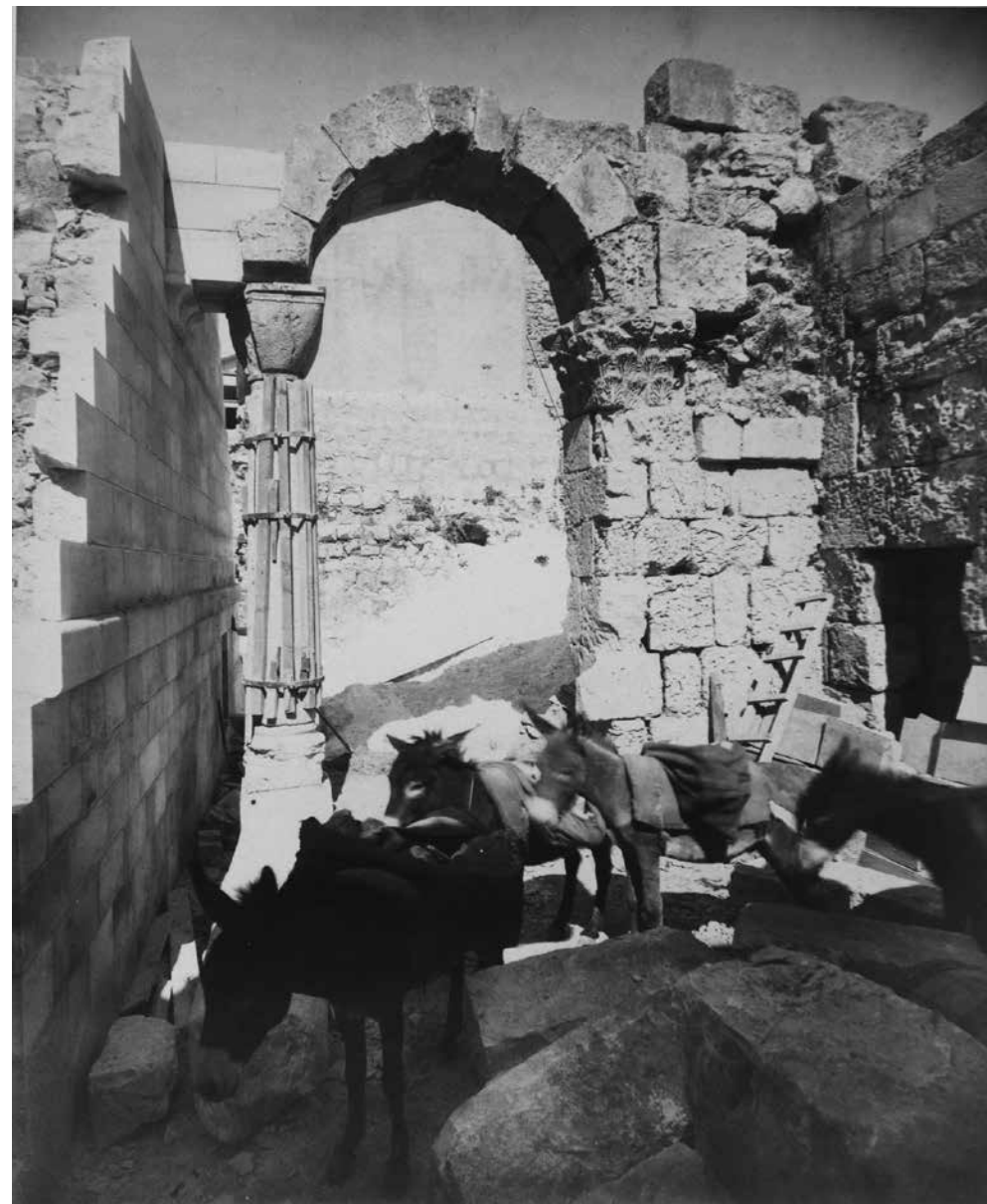
Вид арки с востока, после замены капители, укрепления колонны и реставрации свода. Начало строительства Александровского подворья ИППО. Фото монаха Тимона. 1888–1889 гг. ГМИР
