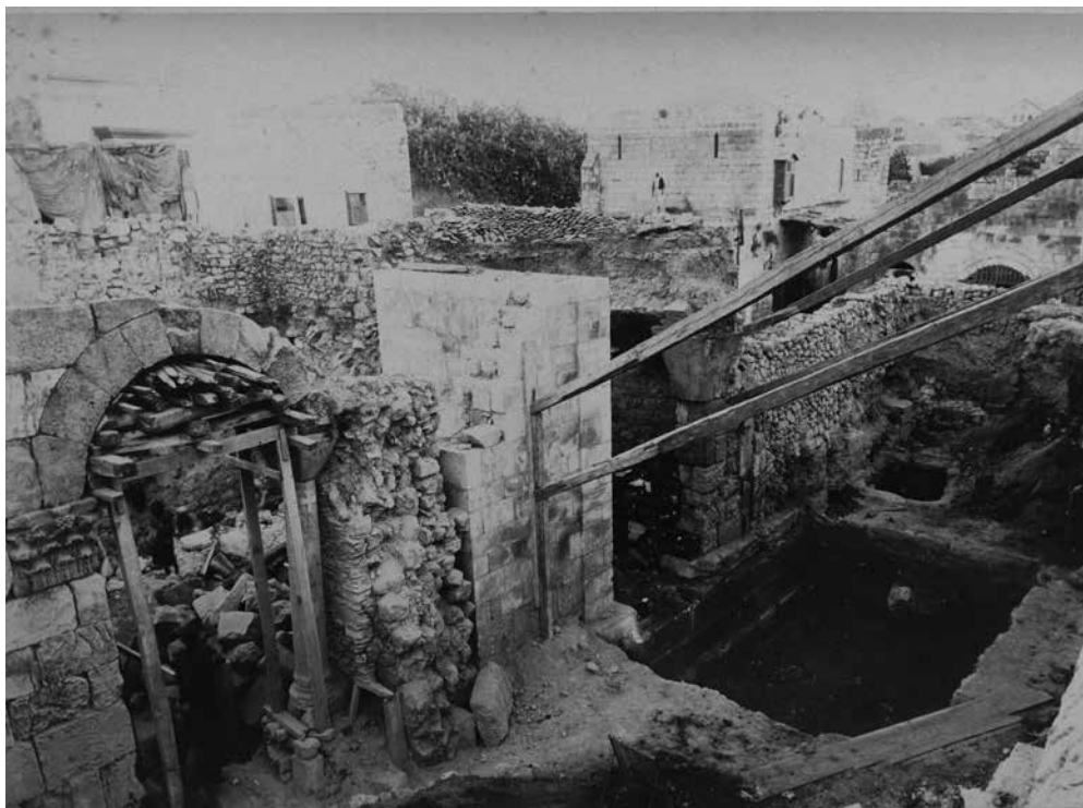
Арка в момент строительства здания подворья на русских раскопках. С юга возводится стена, поставленная на фундамент ворот, под которым виден фрагмент древней стены. Фото монаха Тимона. 1888 г. ГМИР
