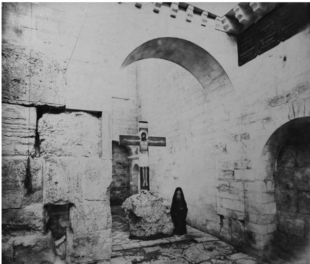
«Голгофа» возле «Порога Судных врат». Камень, предназначавшийся для изготовления капители при реставрации утраченной южной части арки. Фото монаха Тимона. Конец 1890-х гг. ГМИР
