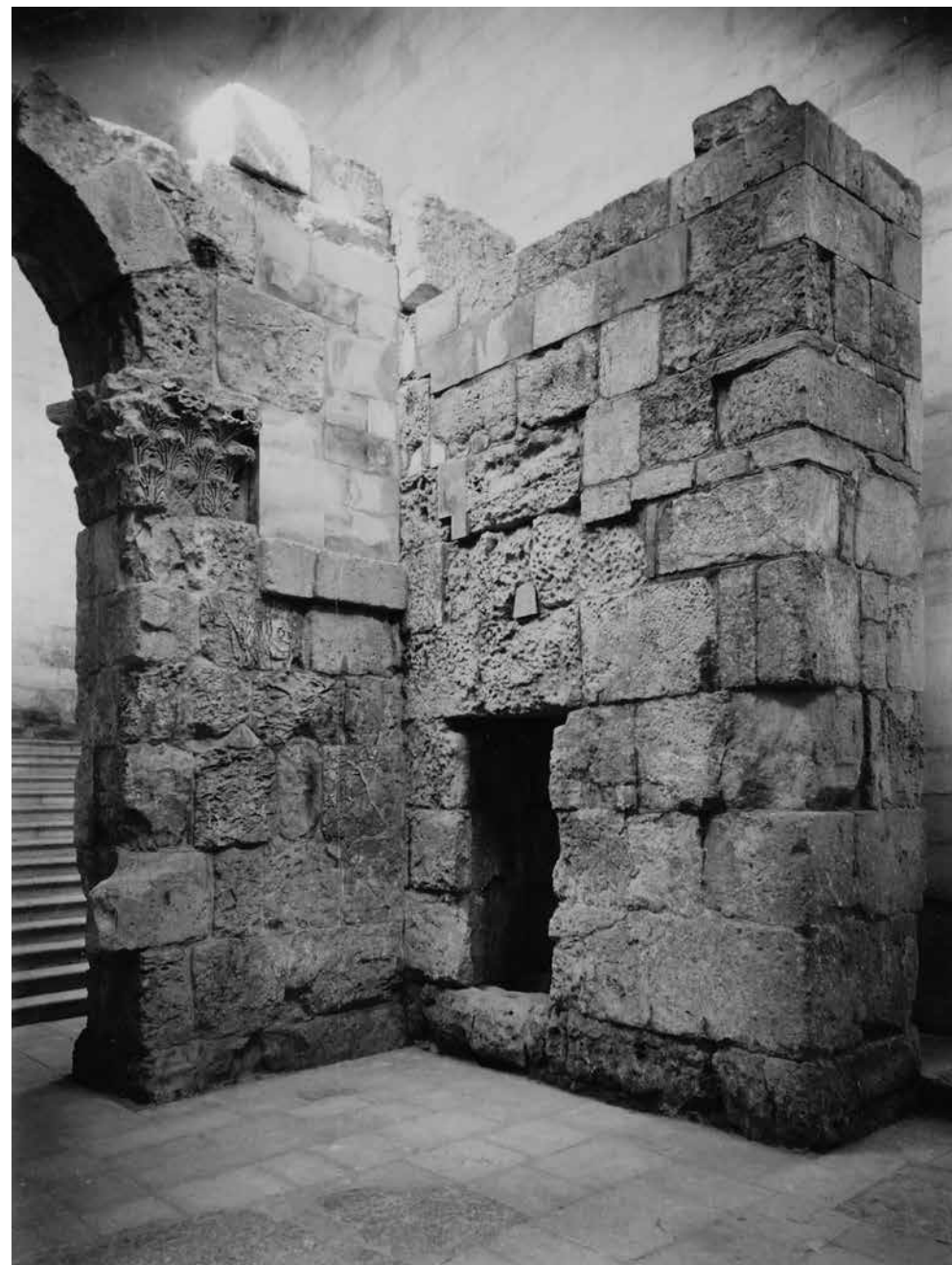
Арка на Александровском подворье ИППО после реставрации. Вид с юго-востока. Фото И. Ф. Барщевского. 1891 г. ГМИР
