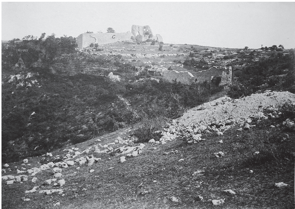
Рис. 1.5. Раскопки Р. Х. Лепера на Мангупе в 1912 г. Общий вид на цитадель на мысе Тешкли-бурун. Справа — отвал из раскопок церкви Св. Георгия (Архив ХГИАМЗ)
