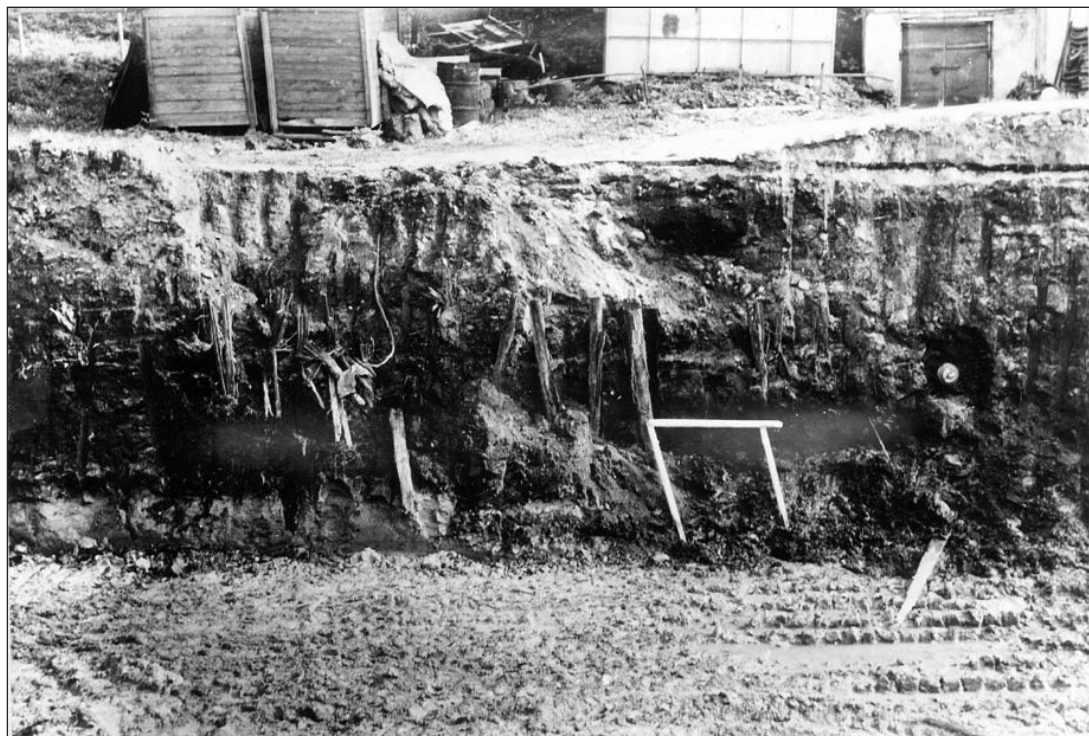
Рис. 22. Остатки свай под фундамент крепости (1596–1602 гг.), арх. Ф. Конь. Ул. Соболева. Фото Н.В. Сапожникова
