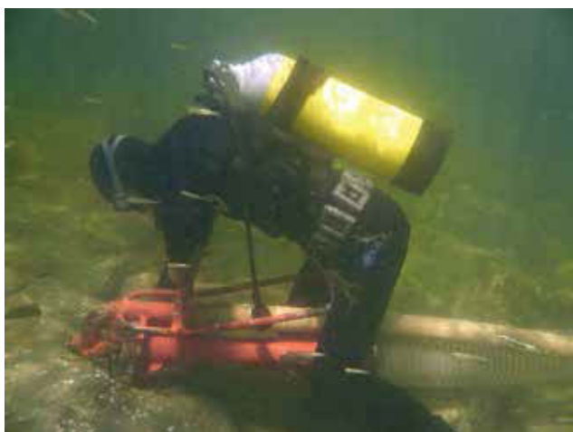
Процесс работы под водой
