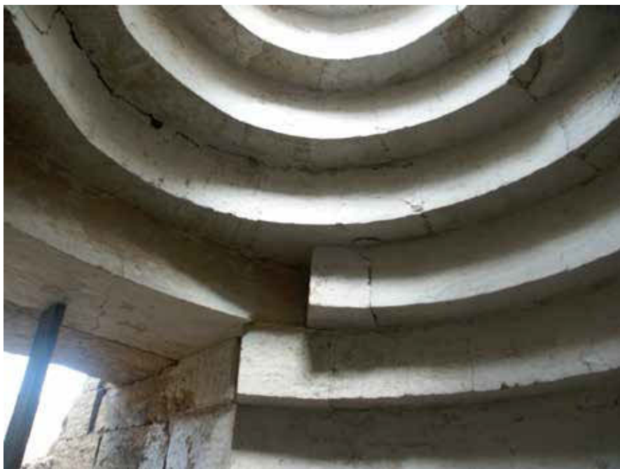
Потолок каменного склепа с уступчатым перекрытием. 4 в. до н.э.
