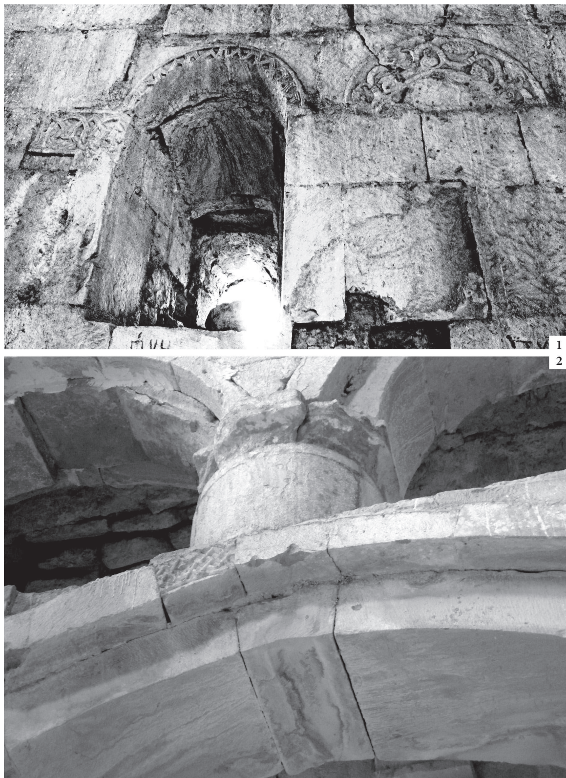
Рис. 4. Переиспользованные блоки, вмурованные в северную (1) и южную (2) стены собора изнутри. Фотографии Д. В. Белецкого
