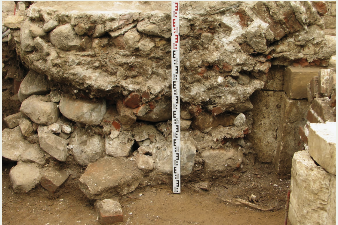
Ил. 32. Фундамент часовни-мавзолея Д.М. Пожарского. Фрагмент южной стенки.
