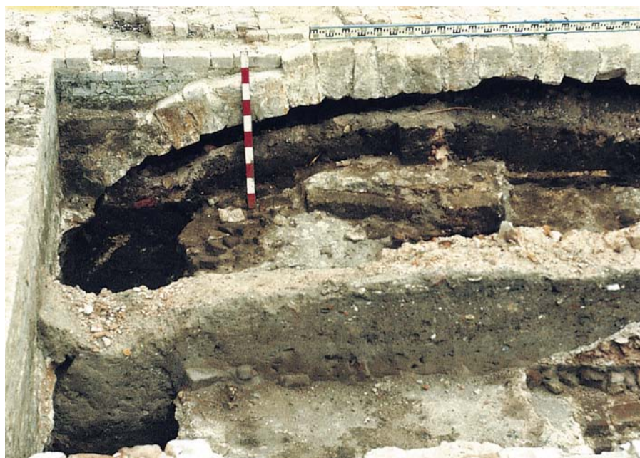
Рис. 5. Разгрузочная арка под западной стеной предела Аверкия Иеропольского, 1636 г.
