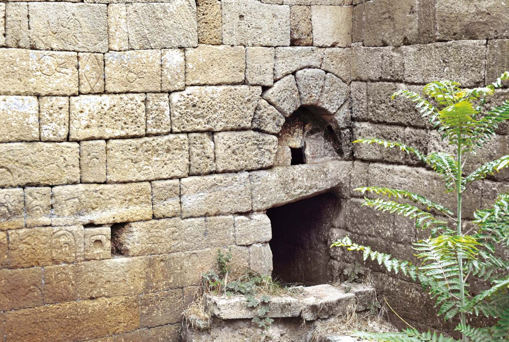
Рис. 7. Дербент. «Ворота Судного дня», вид с севера-востока. В стене вокруг прохода видны следы вбитых средневековых гвоздей и вырезанные знаки.
