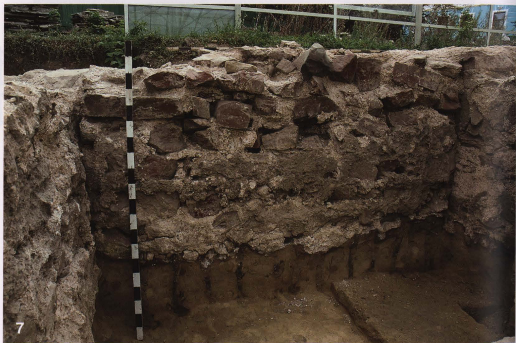
Рис. 11. – 4, 6, 7. Стыковочные швы между участками продольных и поперечных лент фундаментов южной галереи
