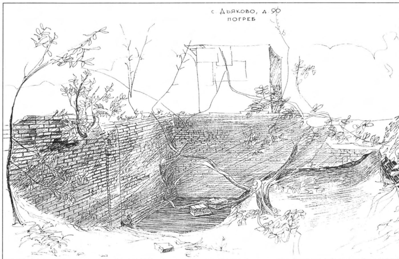
Рис. 8. Погреб 1928 г. для хранения огурцов и капусты на усадьбе Квашниных. Высота сохранившейся части стены – 3,2 м. Рисунок Л.Б. Ланцмана
