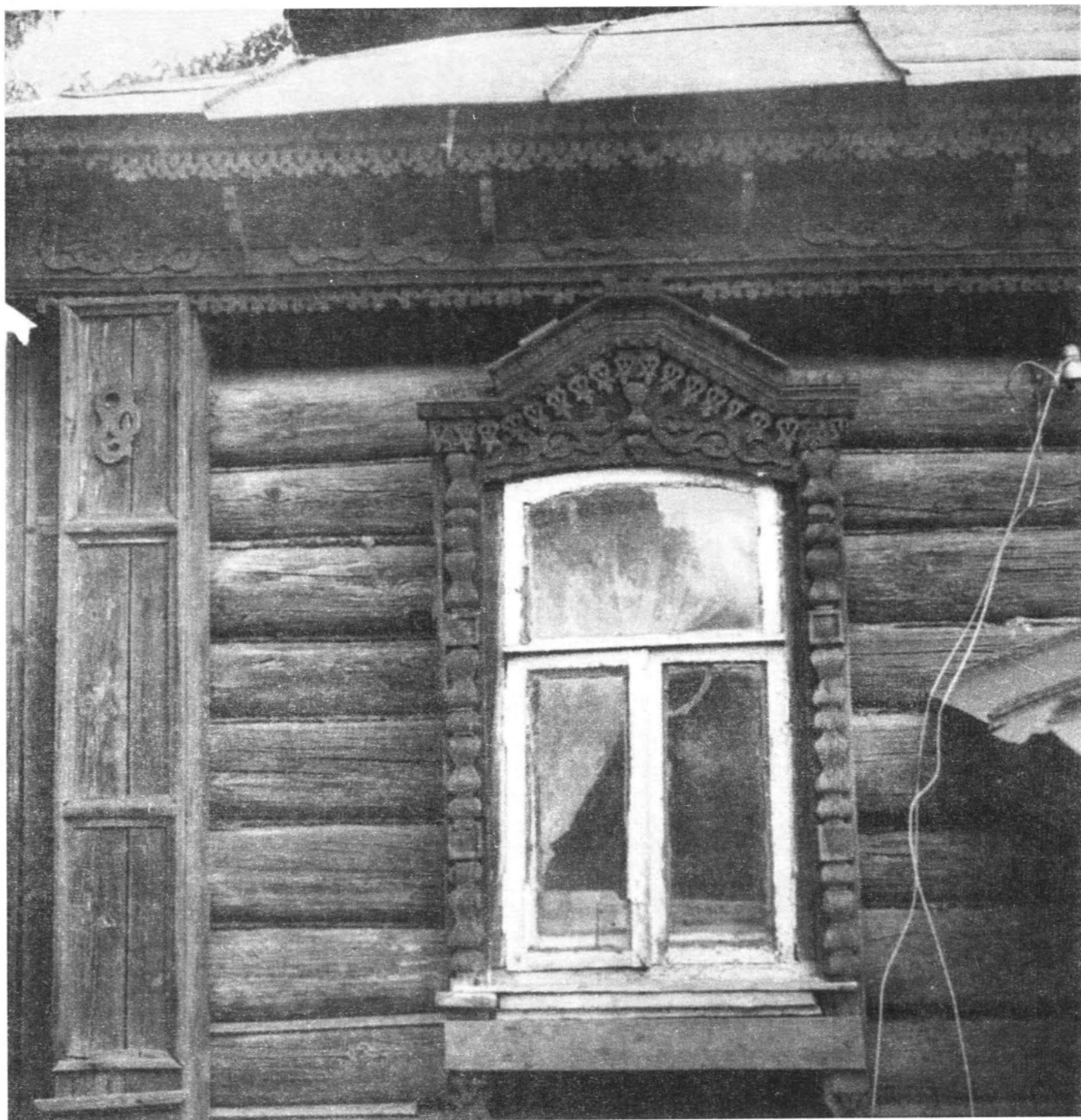
Рис. 3. Окно на южном фасаде дома № 90, справа видна крыша крытого двора. Фото автора, июнь 1987 г.
